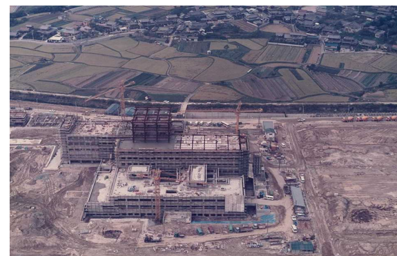
▲ 建設中の市立病院
