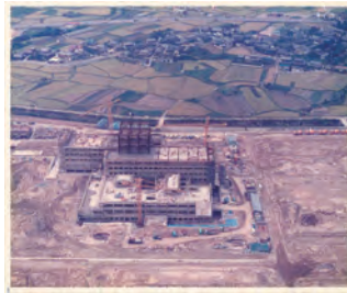
←建設中の市立病院
