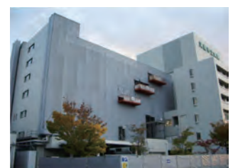
↑大規模改修工事
